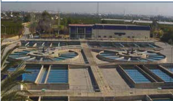
Bombas y ETAP's
